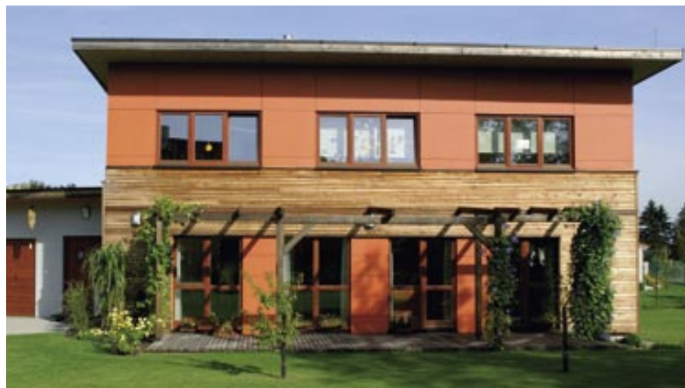
Pro dobře zateplený dům stačí čerpadlo s poměrně malým výkonem. I v posledních velkých mrazech u Novákových „jelo“ čerpadlo bez zapnutí elektrokotle.
