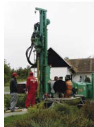
Moderní malé vrtné soupravy umožňují vrtat bez větších škod i v již dokončených zahradách
